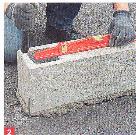
2 Vérifiez et rectifiez si besoin l'alignement et le niveau en vous aidant d'une massette et d'un niveau à bulle.
