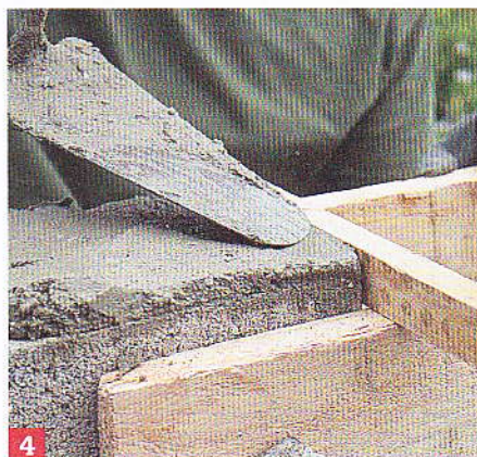
4 Déposez une épaisseur de mortier correspondant à la hauteur finie de la cale sur les parpaings périphériques.
