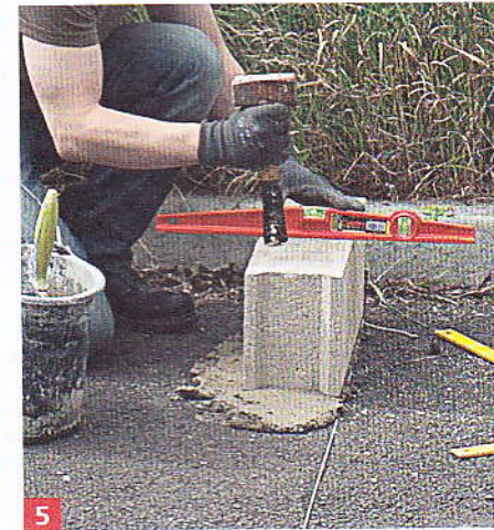
5 À l'extrémité opposée, placez un second parpaing en procédant de la même façon que pour le premier.
