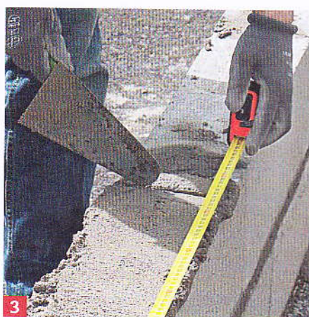
3 Déposez du mortier sur les parpaings en débordant légèrement. Retracez à la truelle les cotes de l'appui.
