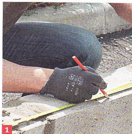
1 Mesurez et notez la distance à laquelle doit débiter la réservation de la fenêtre.
