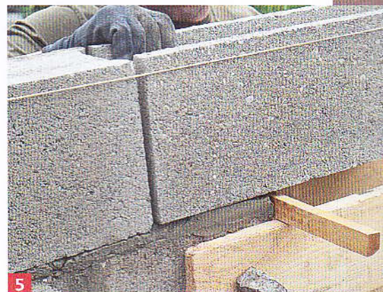
5 Posez le premier bloc de linteau à cheval sur le parpaing et les premières cales. Contrôlez le niveau et l'aplomb.
