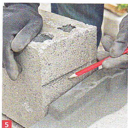
5 Posez un parpaing de tableau sans le coller. Tracez un repère sur le bloc à la hauteur de l'appui.
