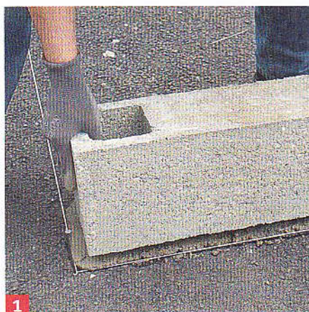
1 Placez un premier bloc d'angle sur un lit de mortier après avoir repéré l'angle au sol avec des cordelettes.
