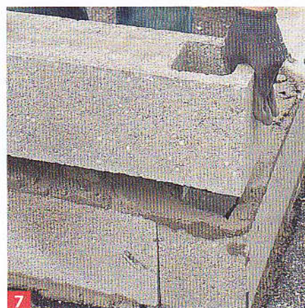
7 Placez un second parpaing d'angle dans le sens opposé pour réaliser une pose en quinconce.
