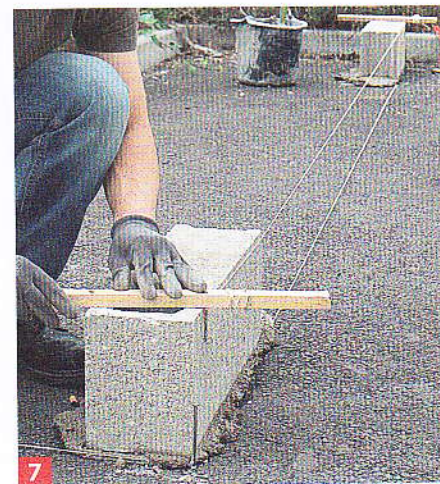
7 Placez une pigne sur le dessus de chacun des parpaings afin d'obtenir l'alignement horizontal avec la cordelette.
