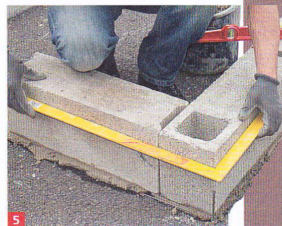
5 Ajustez parfaitement les deux blocs, puis contrôlez l'angle avec une équerre de maçon.
