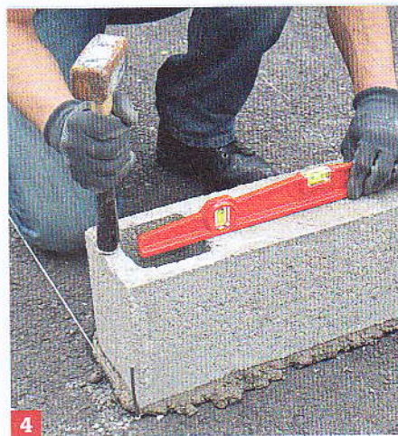
4 Posez le premier parpaing. À la massette, alignez-le sur les cordelettes puis contrôlez l'aplomb au niveau.
