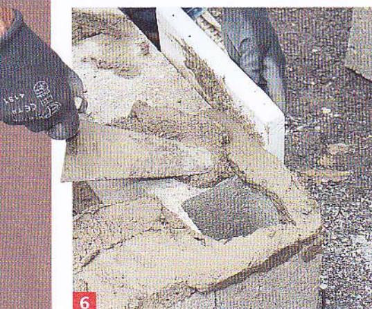
6 Garnissez le joint entre les deux parpaings. Déposez un lit de mortier sur le dessus des parpaings.
