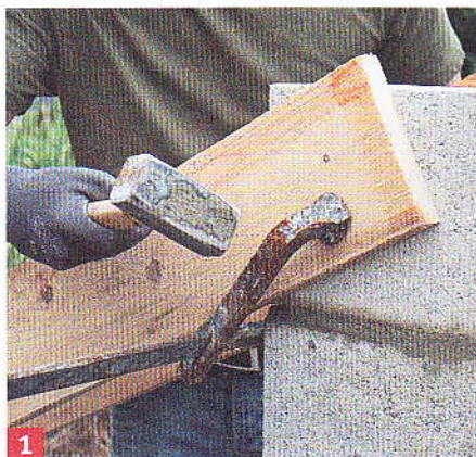
1 À l'aide de deux serre-joints de maçon, positionnez deux planches de coffrage en vis à vis sur le parpaing.
