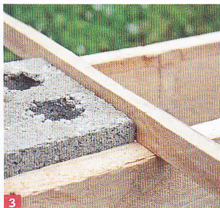
3 Placez des cales en bois (env. 2 cm d'épaisseur) contre le parpaing, puis tous les 20 cm sur les deux planches.
