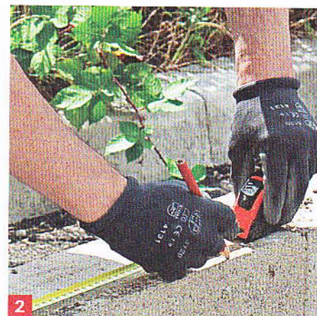
2 Notez la longueur de l'appui de fenêtre à poser et reportez sa cote à son emplacement sur les parpaings.
