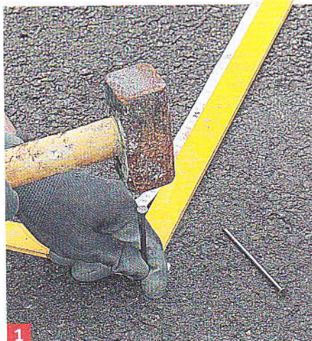
1 Mesurez et repérez au sol l'emplacement du futur mur en plantant un clou aux quatre coins extérieurs.
