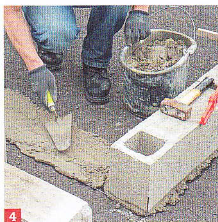
4 Déposez un lit de mortier au sol perpendiculairement au premier bloc et posez un parpaing standard.
