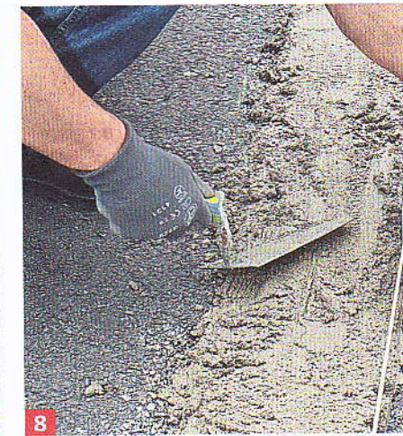
8 Déposez un lit de mortier d'environ 1 cm d'épaisseur sur toute la longueur entre les deux parpaings.
