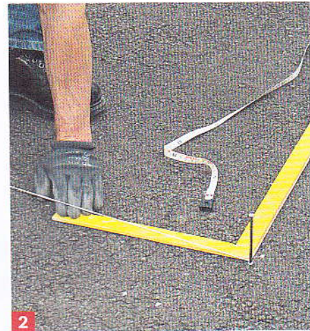
2 À chaque clou, attachez une cordelette qui servira à contrôler l'alignement des rangées de parpaings.
