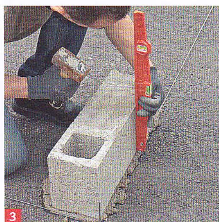
3 Vérifiez l'aplomb en vous aidant du niveau à bulle. Rectifiez la position par quelques coups de massette.
