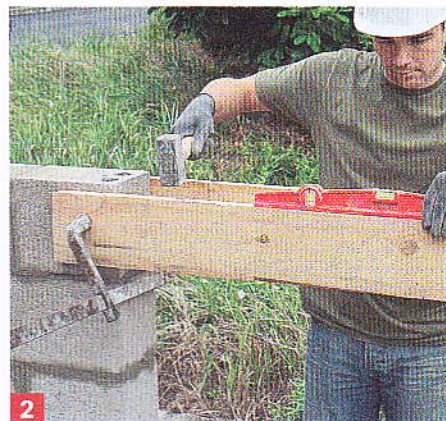
2 Ajustez les planches (parallèles et de niveau). Laissez 1 cm entre le haut de la planche et le haut du parpaing.
