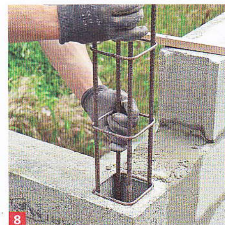
8 En fin de montage, glissez le ferrailage dans les blocs d'angle puis coulez du béton pour rigidifier le montage.
