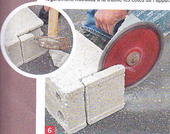
6 À l'aide d'une meuleuse et de la massette, réalisez une encoche d'environ 4 cm de profondeur.
