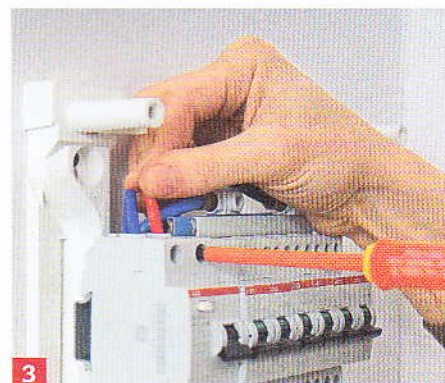
3 Raccordez l'interrupteur différentiel aux conducteurs provenant de votre tableau principal. Dans notre exemple, le raccordement se fait par le haut du module.
