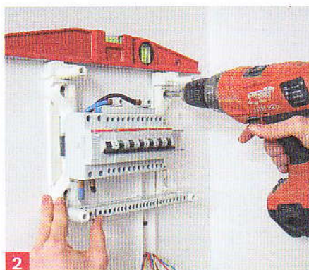
2 Fixez solidement votre tableau secondaire pré-équipé à un emplacement facile d'accès et à hauteur des yeux. Vérifiez bien l'aplomb de l'ensemble.
