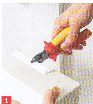
1 Pour intégrer les goulottes dans le tableau, découpez le capot en suivant les compartiments prévus à cet effet.
