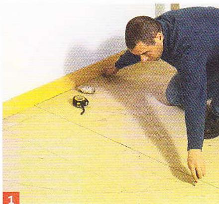
**1** Commencez par tracer la courbure de la cloison au sol. En guise de compas, vous pouvez utiliser une cordelette de la longueur voulue fixée à une vis.
