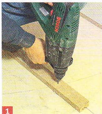
**1** Au sol, percez et fixez une semelle en bois avec des chevilles et des vis adaptées sur le tracé de la future cloison.
