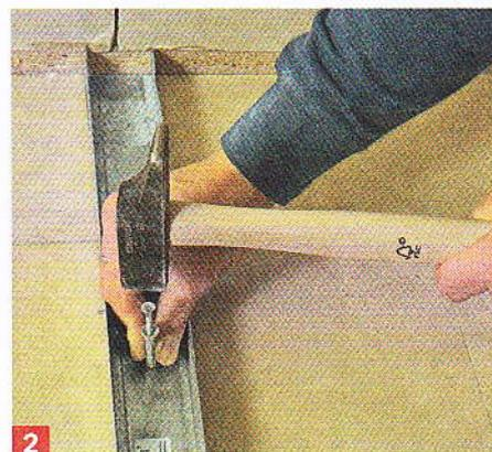
2 Suivant la nature du revêtement, utilisez des chevilles à frapper ou des vis pour fixer la lisse au sol. Contrôlez l'implantation tout au long de l'opération.
