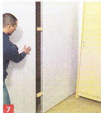
**7** Glissez le second panneau jusqu'à l'encastrez sur les clavettes. Vissez-les de part et d'autre de la plaque.
