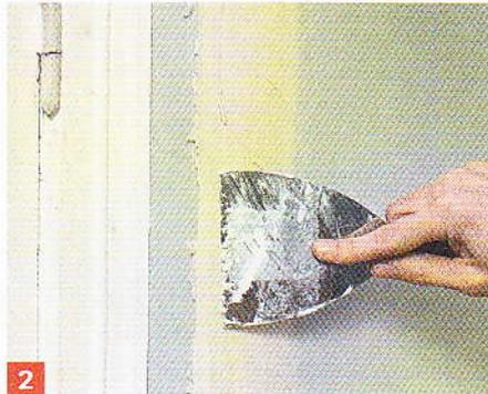
2 Lissez l'arête au couteau et laissez sécher l'ensemble. Appliquez ensuite la seconde couche d'enduit sur la bande armée en respectant l'angle de l'arête.
