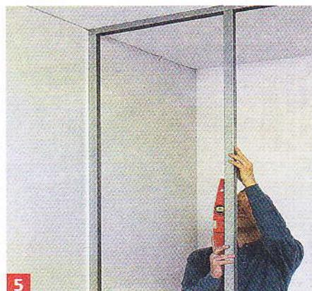
5 Espacez les montants verticaux tous les 60 cm. Vérifiez qu'ils soient parfaitement d'aplomb avant de les visser (ou de les sertir) sur les rails de sol et de plafond.
