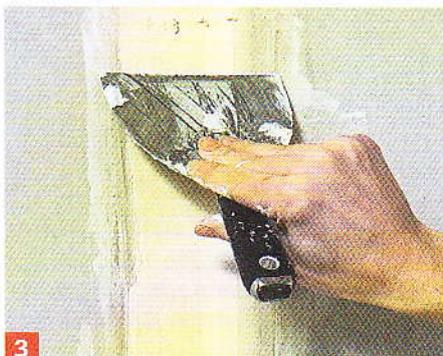
3 Lissez le joint pour obtenir une parfaite adhérence, puis laissez sécher l'ensemble. Passez ensuite une seconde couche d'enduit sur la bande de façon régulière.
