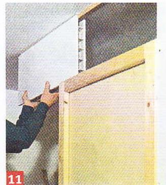
**11** Découpez un morceau de panneau alvéolé aux bonnes dimensions et glissez-le sur le bâti pour réaliser l'imposte.
