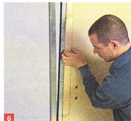
6 Pour poser la porte, vissez une lisse métallique sur le bâti de porte, puis fixez-le au montant déjà en place. Poursuivez le montage de la structure.
