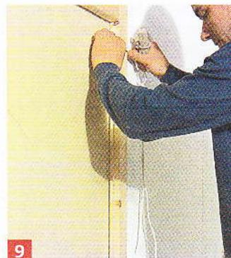
**9** Positionnez le bloc porte contre le panneau. Vérifiez l'aplomb avant de fixer le bâti dans le montant déjà intégré.
