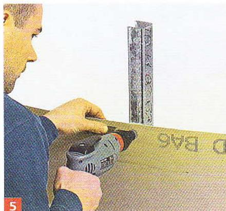
**5** Vissez la première plaque de plâtre sur les montants verticaux. Cette opération permet de rigidifier l'ensemble de la structure avant de mettre le haut en place.
