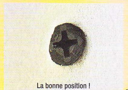
Grâce à un embout spécifique qui permet de régler la profondeur de vissage, la visseuse à plaque de plâtre assure un travail net, rapide et plus précis qu'une visseuse traditionnelle. La vis est à la bonne profondeur dans la plaque, ce qui facilite ensuite la pose des bandes de calicot et celle de l'enduit de finition.
