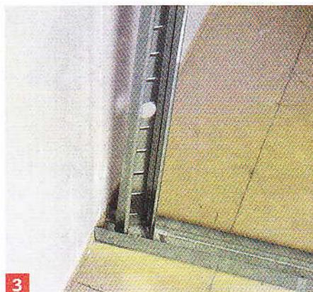
3 Découpez un montant vertical et enclenchez-le de biais dans la lisse. Faites-le pivoter contre le mur et vissez-le en contrôlant l'aplomb avec un niveau.
